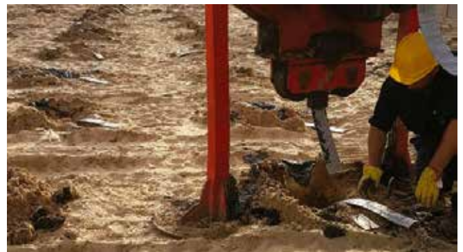
Operario cortando dren
