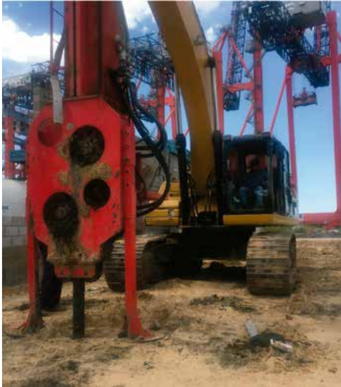
Hincadora en funcionamiento
