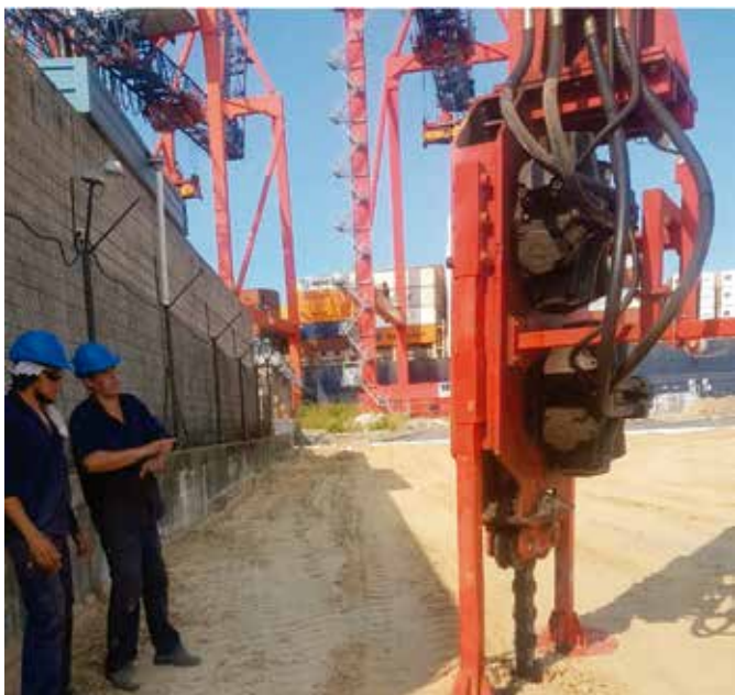
Hincadora en funcionamiento
