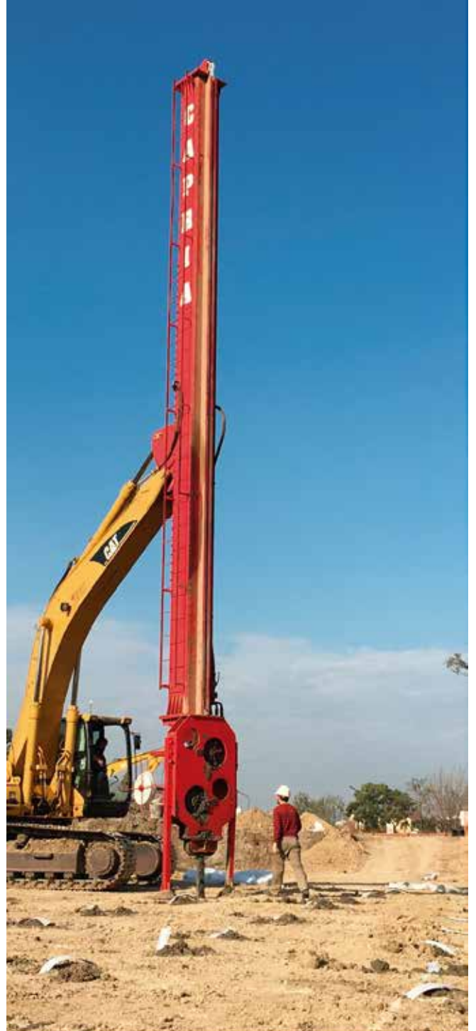
Hincadora en funcionamiento
