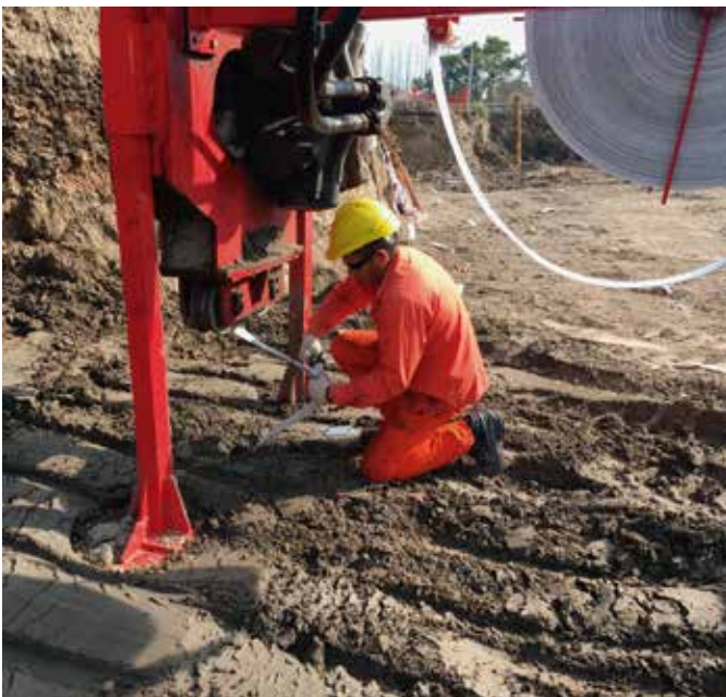
Operario cortando Dren
