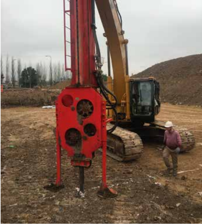
Hincadora en funcionamiento
