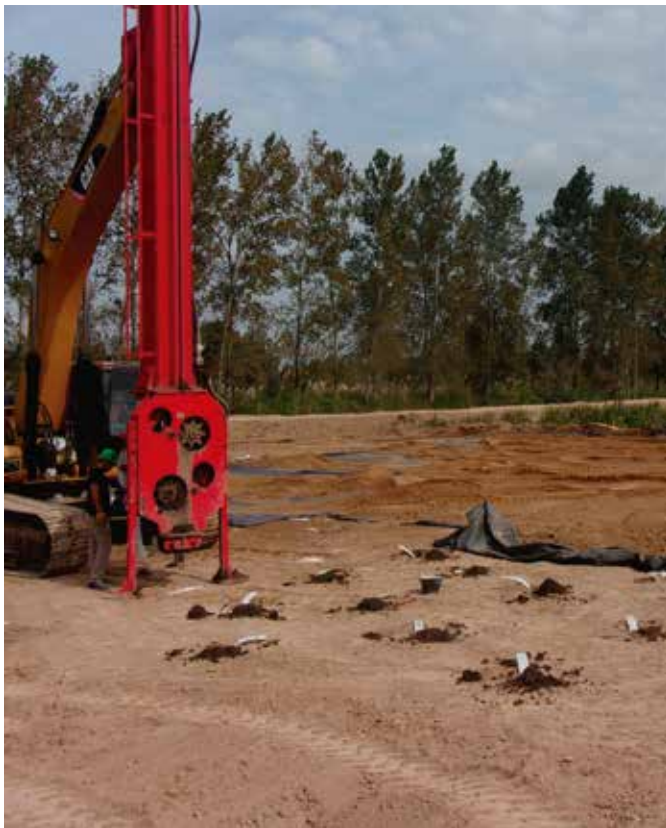
Hincadora en funcionamiento
