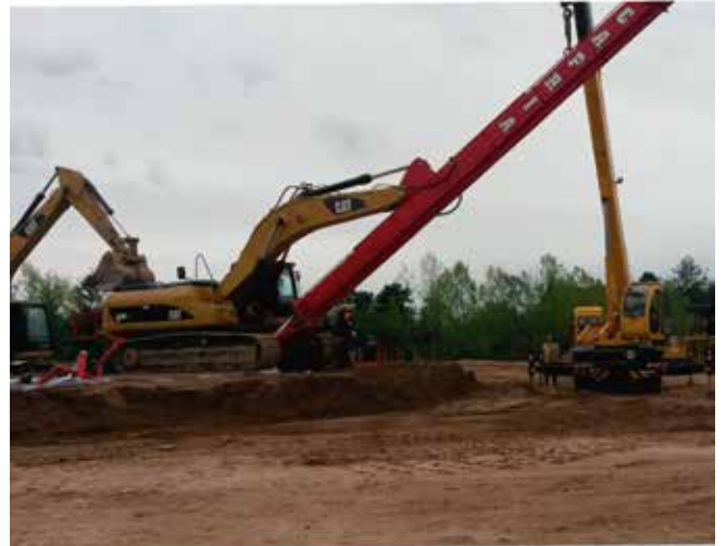
Montaje de hincadora de geodrenes
