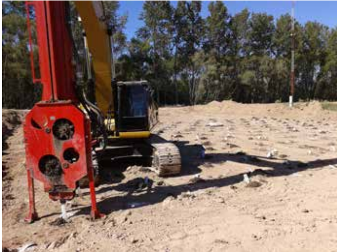
Hincadora en funcionamiento
