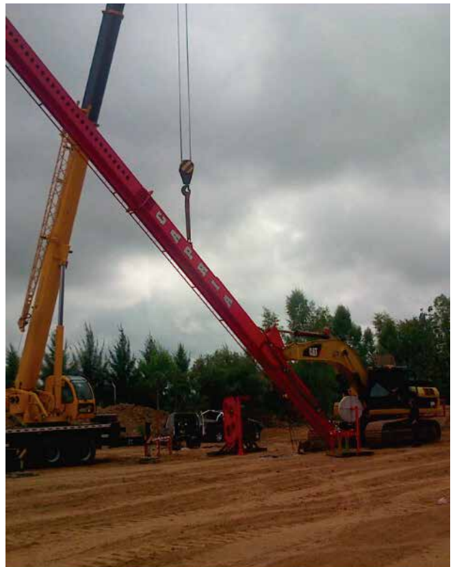
Montaje de hincadora de geodrenes
