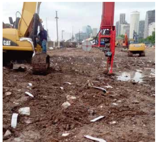
Hincadora en funcionamiento
