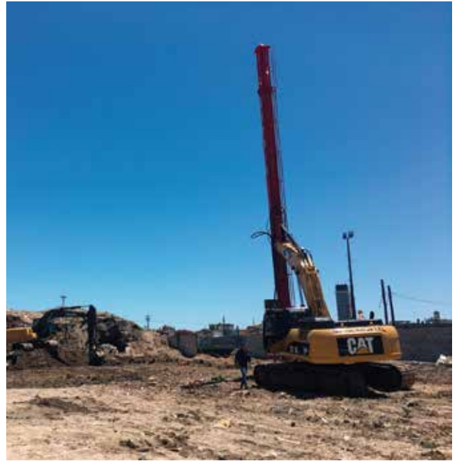
Hincadora en funcionamiento
