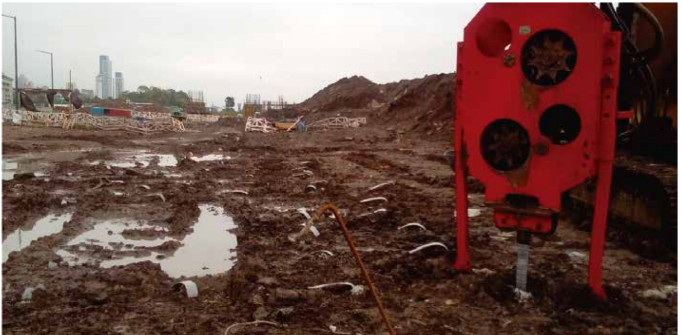
Hincadora en funcionamiento
