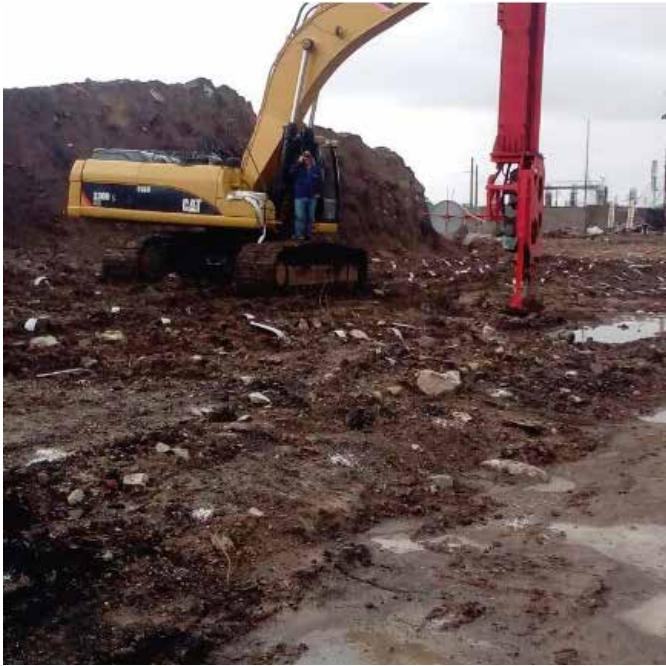
Hincadora en funcionamiento
